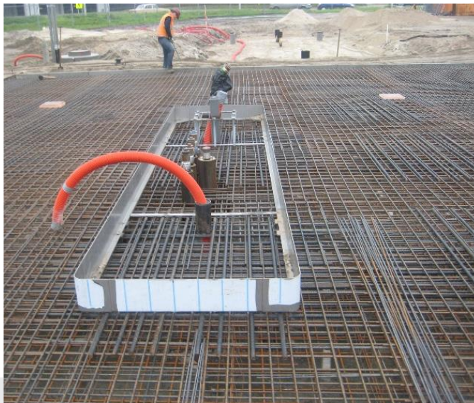
Foto: Voorbeeld in te storten onderdelen/wapinging.
