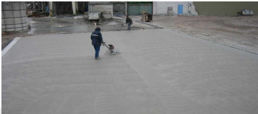
Foto: Voorbeeld van een vlakke vloerafwerking.
